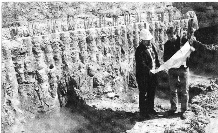
Bald geht's los: die beiden Bauleiter Karl-Heinz Bielmeier (r.) und Oliver Bauer mit den Plänen.
